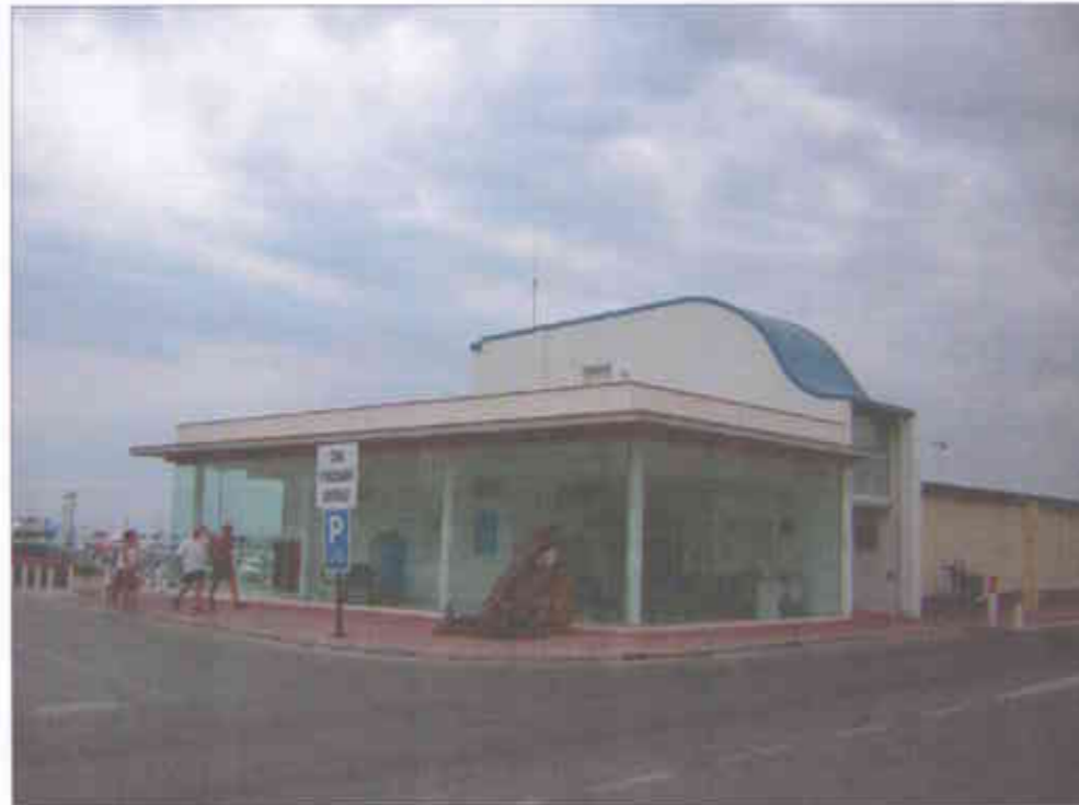
Edifici de serveis portuaris
