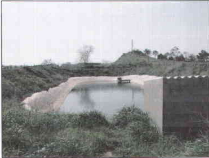
Foto 1. Bassa de reciclatge de les aigües de neteja dels filtres de piscines, utilitzada pel reg.
