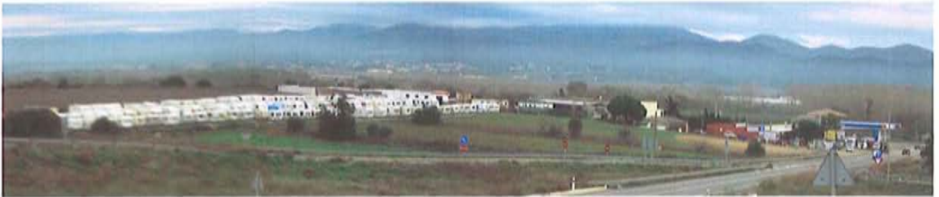
Vista panoràmica del sector des del nou enllaç sobre la carretera nacional
