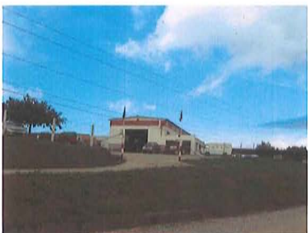
Taller de maquinaria agrícola des del canal
