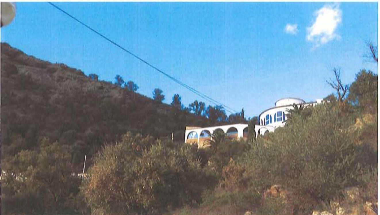
Edificacions existents a l'àmbit
