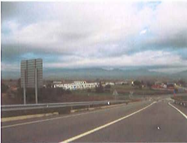
Visió general del sector des del vial d'accés a la carretera general
