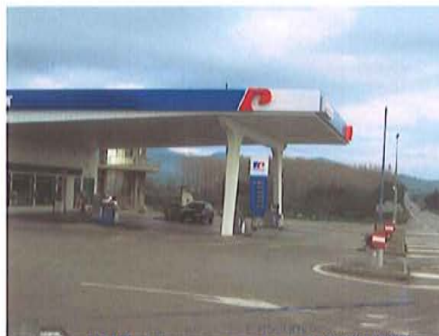
Estació de servei
