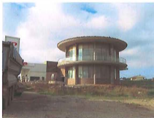
Edifici annexa a l'estació de servei
