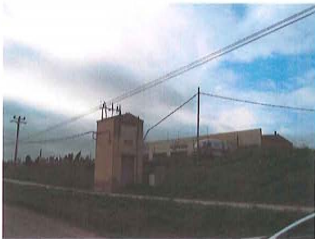
Nau industrial des del camí que voreja el canal (1)
