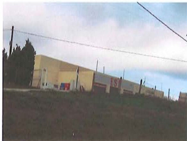
Nau industrial des del camí que voreja el canal (2)
