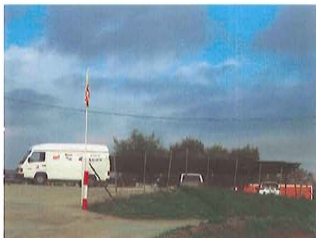
Cobert d'aparcament a l'accés del taller de maquinaria agrícola
