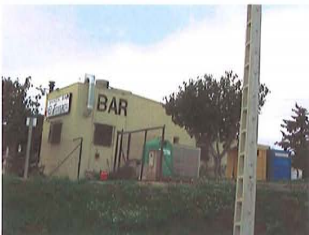
Bar-restaurant. Visió lateral des del camí
