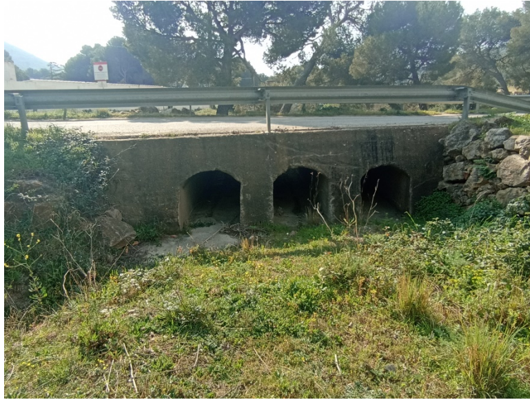
Imatge 8. Vista de les dues estructures hidràuliques de la carretera d'accés
